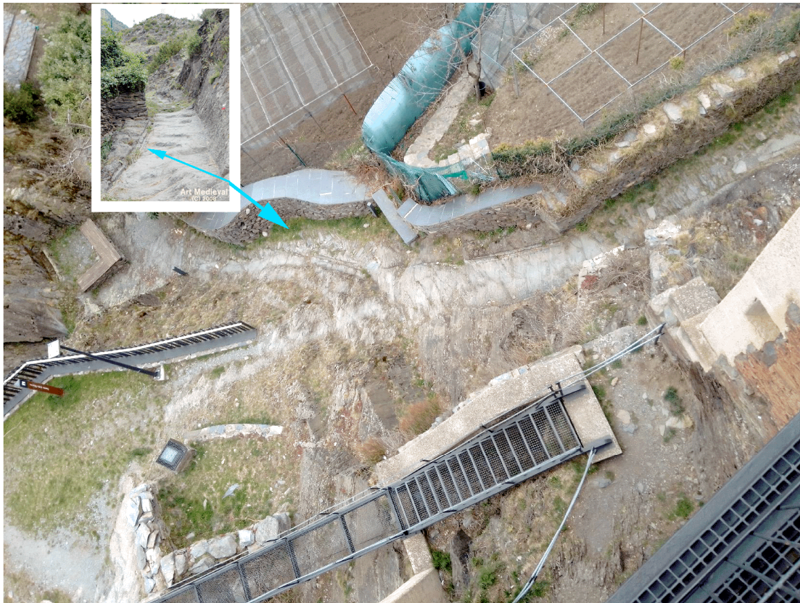
Solc al substrat rocós que canalitza l'aigua pel camí
